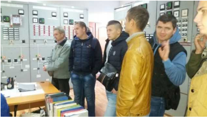
Виїзне практичне заняття з дисципліни "Основи електропостачання" на підстанцію "Мелітополь-330 кВ"
