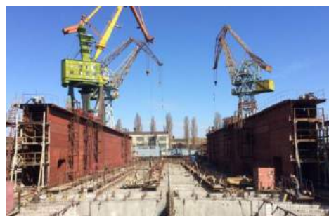
Рисунок 6 – постройка композитного автономного плавучего дока грузоподъемностью 7100 т в Херсонском государственном заводе «Паллада» [7]
