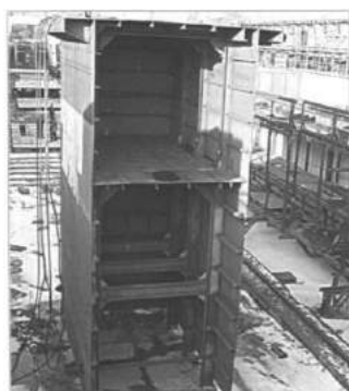
Рисунок 8 - Блок-секция металлической башни, изготовленная на стенде в цехе
