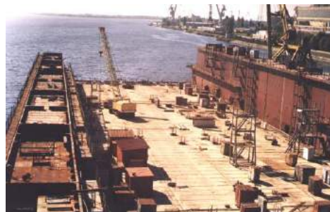
Рисунок 11 - Монтаж башен дока на плаву
