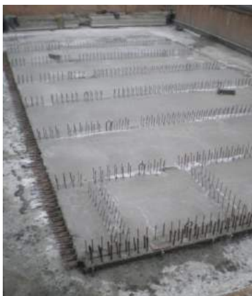
Рисунок 4 - Плоская железобетонная секция с закладными деталями и выпусками, изготовленная в цехе для понтона дока
