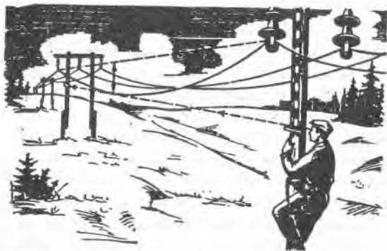
Рис. 3.3. Перевірка стріли провисання проводів у прогоні ПЛ
