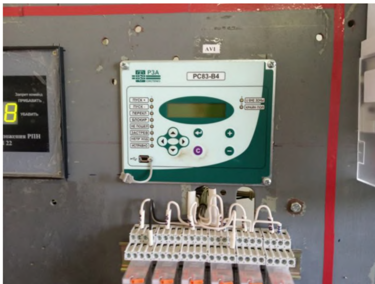
Рисунок 5. Мікропроцесорний пристрій РС 83-В4
