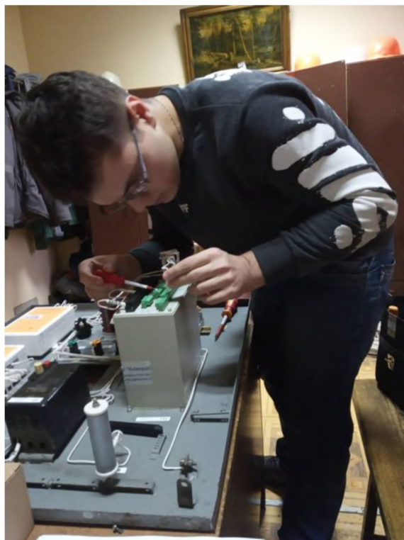
Рисунок 1. Монтаж та наладка новітнього обладнання
