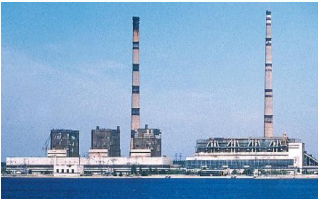
Рис. 4. Загальний вигляд Запорізької теплової електростанції
