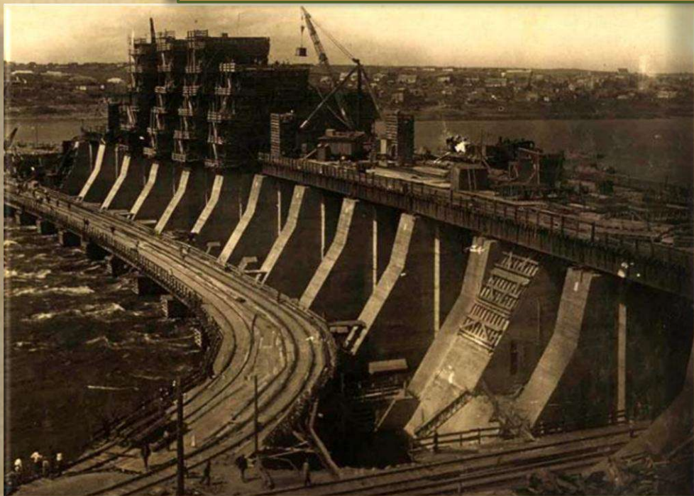
Спорудження Дніпровської ГЕС. Фото 1930 року
