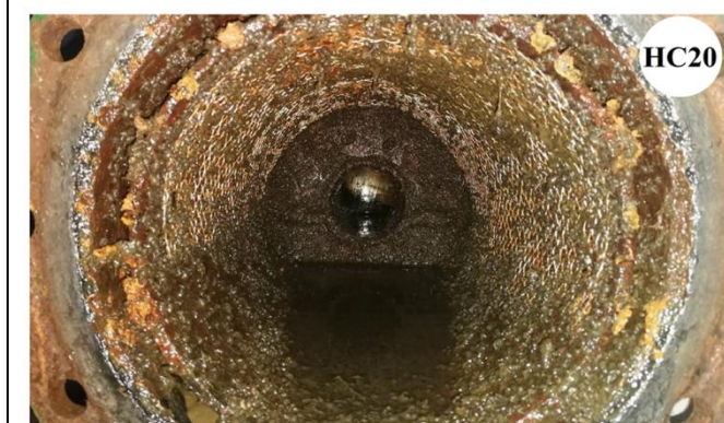
Рис. 2. Загальний вигляд внутрішніх поверхонь сіток фільтрів HC19 і HC20. Помітним є менше біообростання сіток HC20 по відношенню до сіток HC19.
