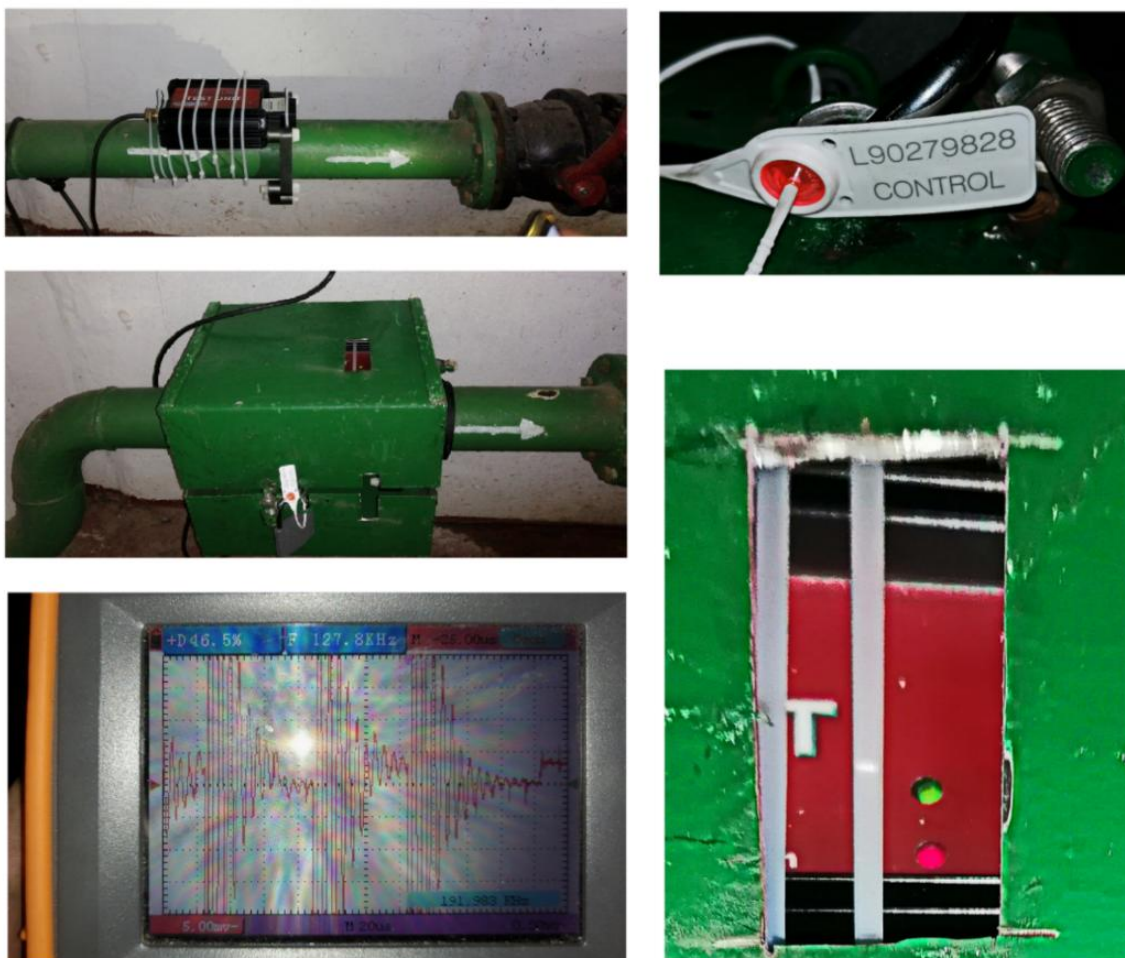
Рис. 1. Загальний вигляд контрольних елементів в процесі монтажу і запуску приладу «HydroFLOW»
