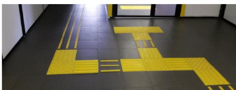
Рисунок 1 – Вимоги щодо інклюзивності (засоби орієнтування) при проектуванні захисних споруд та СПП у складі закладів вищої освіти [2].
