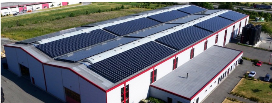
Рис. 2. Встановленні сонячні батареї на даху ферми
