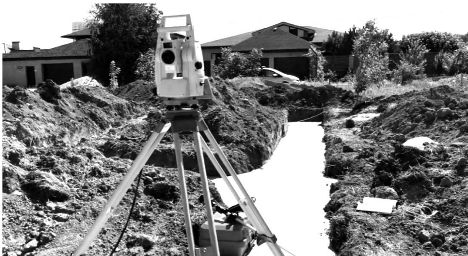
Рис. 1. Перевірка точності земляних робіт для будівництва фундаменту
