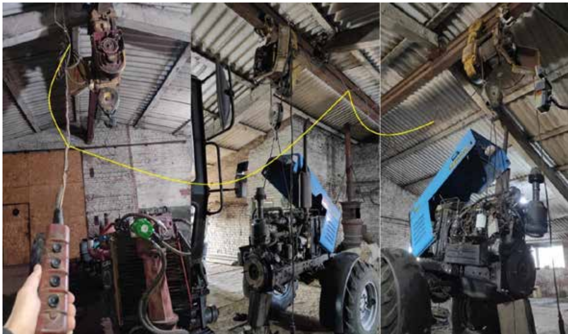
Рис. 2. Виконання проводки тельфера гнучким багатожильним кабелем
