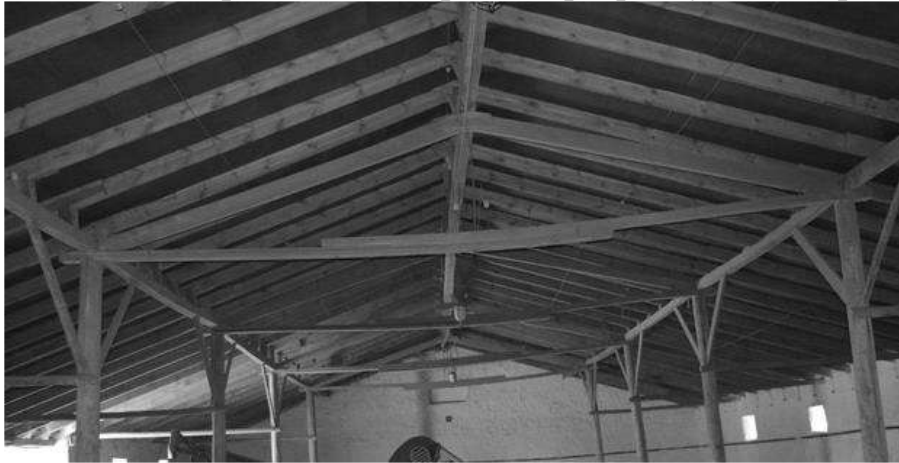
Рис. 1. Внутрішні несучі дерев'яні конструкції зерноскладу №2
