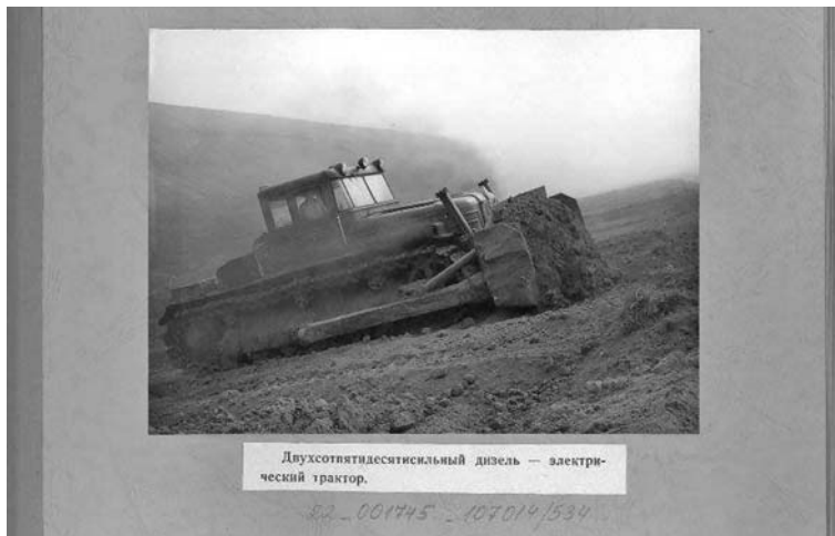
250-сильний дизель – електротрактор на будівництві Північнокримського каналу на Херсонщині, 1963 рік
